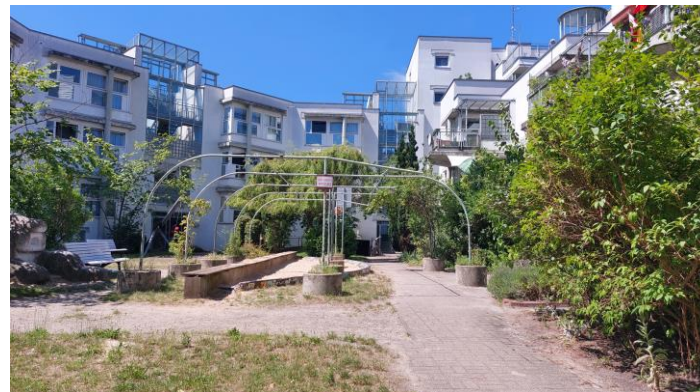
LiMa-Wohnhof, Hof, Zustand heute
