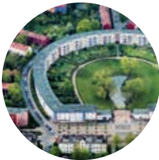
Aktuelle Luftaufnahme des Hufeisens
