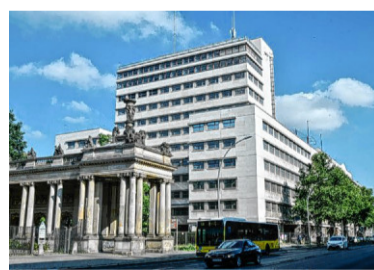
Die Königskolonnen (l.) neben dem leer stehenden Gebäude.
